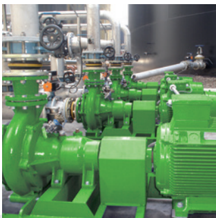
MAGNUM SX Dickstoffpumpe Getriebe- und Lagerstuhlausführung
