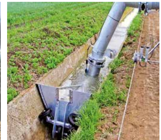
Conduite d'aspiration posée sur canal béton
