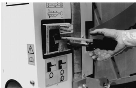
2. Tirar la palanca de desconexión en posición de desconexión y apretándola lentamente y con cuidado hacia abajo...
