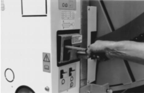
... y presionando cuidadosamente de forma dosificada la palanca de desconexión, distender el tubo PE.
