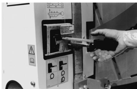
Poner la palanca de conmutación en la posición „desconectado“...
