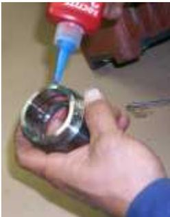
Appliquer de la Loctite sur le filetage.
