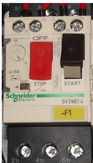
Fig. 15-3 Motor protection circuit breaker F1
