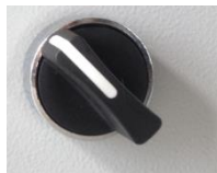
Abbildung 20 Hebel und Schalterstellung im Automatikbetrieb mit Klarlaufpumpe
