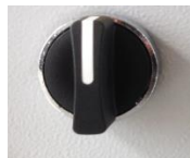
Abbildung 20 Hebel und Schalterstellung im Automatikbetrieb mit Klarlaufpumpe
