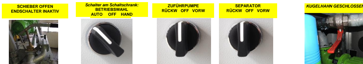
Abbildung 21 Hebel und Schalterstellung im Automatikbetrieb ohne Klarlaufpumpe
