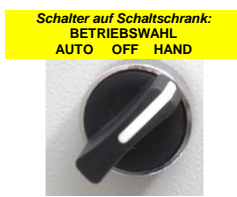
Abbildung 22 Hebel und Schalterstellung im Handbetrieb mit Klarlaufpumpe
