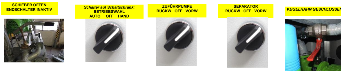
Abbildung 23 Hebel und Schalterstellung im Handbetrieb ohne Klarlaufpumpe
