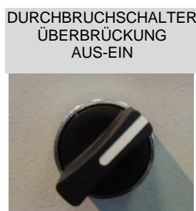
Abbildung 11 Durchbruchschalter Überbrückung
