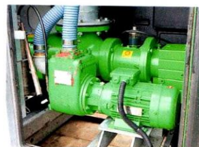
Die Kreiselpumpe (vorne) pumpt die separierte flüssige Phase in das Lager oder in Transportbehälter.
