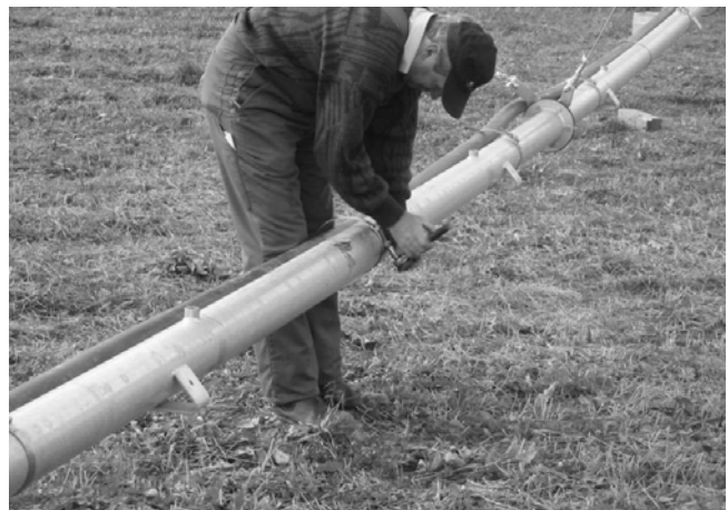
Die PE-Rohrleitung von der Druckerhöhungspumpe zum Endregner wird mit Schellen am Überhangrohr befestigt.
