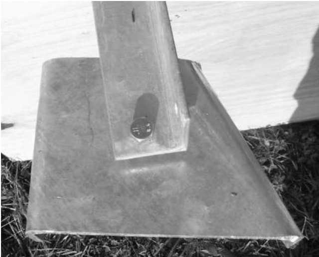
Montage der Konsolen L und R auf die Überhangstreben.
